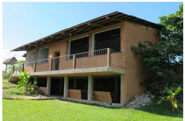
Fertiggestelltes Werkunterrichtsgebäude mit Lehmverputz
