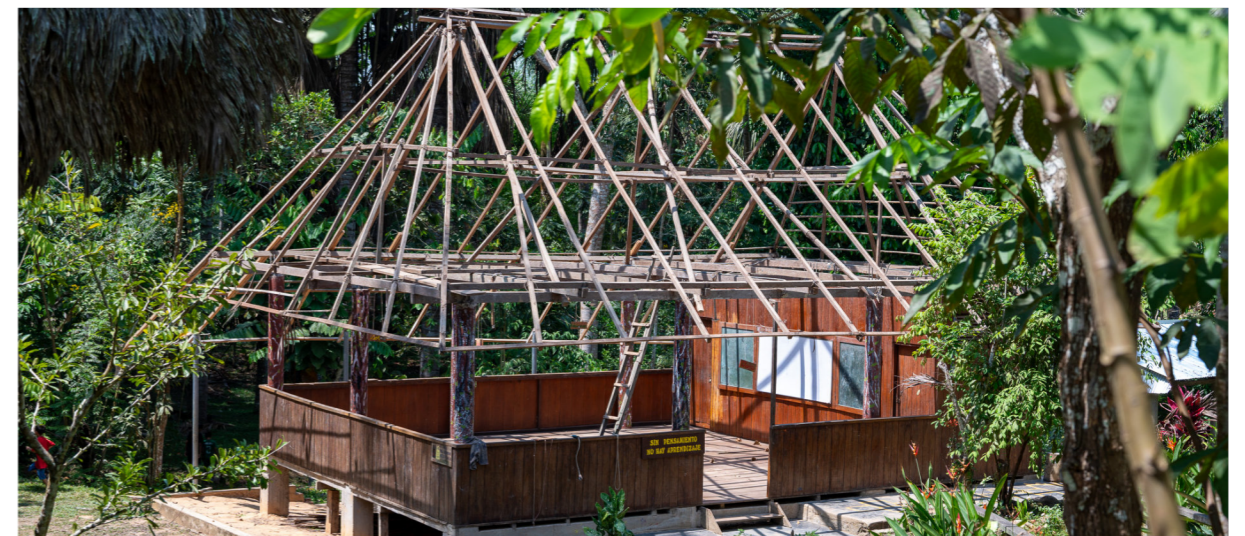
Dachdeckung eines Schulzimmers
