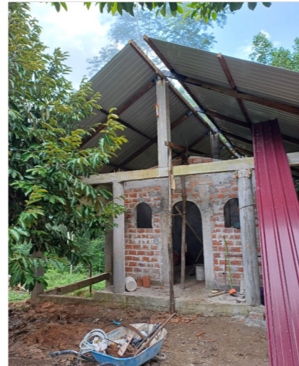
Bau der Waldbibliothek
