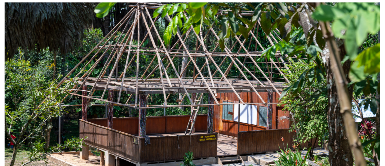
Dachdeckung eines Schulzimmers
